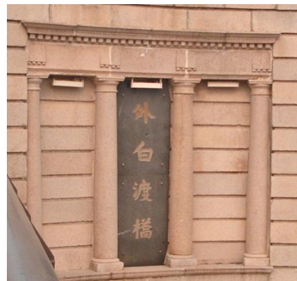
外白渡橋のネームプレート
