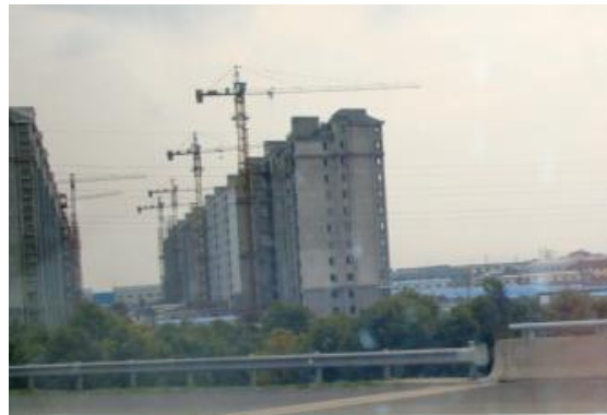
建設中の高層住宅ビル群
