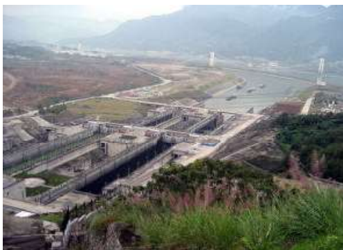
第6図 2通路 5段階閘門式船舶通路
